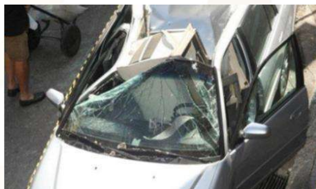
Queda de equipamento de ar, no momento de sua instalação, devido a fragilidade do suporte.
