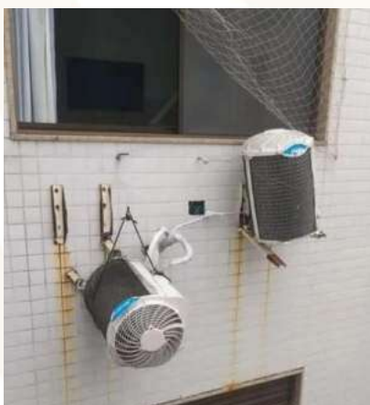
Queda de equipamento de ar, no momento de sua instalação, devido a fragilidade do suporte.
